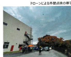
ドローンによる外壁点検の様子
