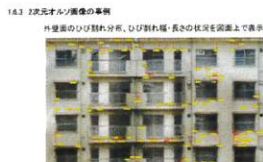
図1.16 南庫外壁のひび割れ分布図(オルソ画像)
